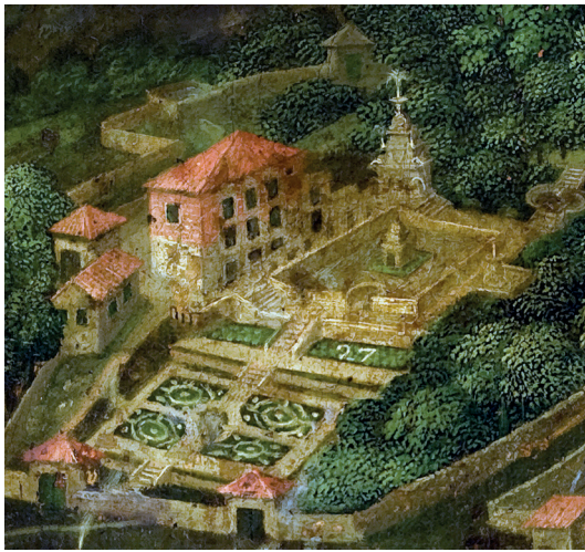
Figura 4. Buonaventura Ligli, Vista de Béjar (1726-1727), fragmentos con el conjunto de El Bosque y con la Fuente de la Sábana.
