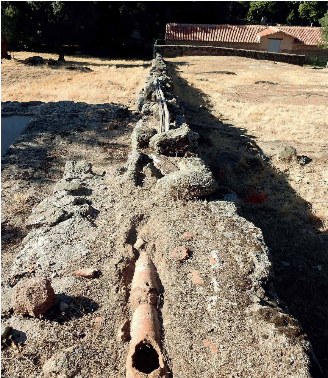
Figura 8. Conducción de arcaduces de cerámica entre el estanquillo y la fuente.
