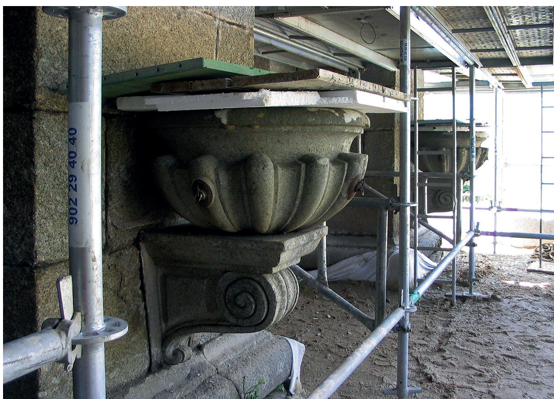
Figura 10. Obras de rehabilitación de la fuente en 2008-2009.
