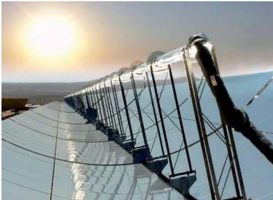
Ilustración 4. Captadores solares cilindro-parabólicos
