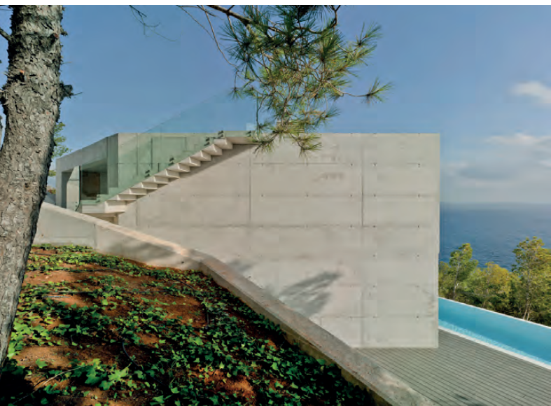
Figura 8. Fachada exterior: detalle juntas encofrado. Archivo Singular Studio (2016). ©David Frutos / Figure 8. Exterior façade: formwork joint's detail. Singular Studio's archive (2016). ©David Frutos.
