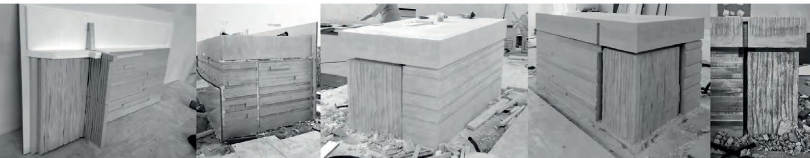
Figura 12. Proceso de elaboración del encofrado y desencofrado del altar. Espinosa+ Moreno arquitectos (2015) / Figure 12. Process of elaboration of the making and removing of the formworks for the altar. Espinosa+ Moreno arquitectos (2015).
