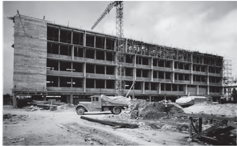
Figura 11. Imagen de visita de obra. Vista desde el patio central hacia el edificio principal. 15 de mayo de 1960. Pablo Navarro Alvargonzález / Figure 11. Image of work visit. View from the central patio towards the main building. May 15 th , 1960. Pablo Navarro Alvargonzález.
