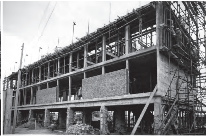
Figura 7. Imagen de visita de obra donde se aprecia la cautela en el curado del hormigón mediante la protección con sacos de yute en constante humectación. 24 de febrero de 1960. Pablo Navarro Alvargonzález / Figure 7. Work visit image where caution is observed in the curing of the concrete by means of the protection with jute sacks in constant humidification. February 24th, 1960. Pablo Navarro Alvargonzález.
