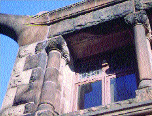
1. En el ejemplo de la biblioteca de Quincy, las patologías de los muros y cubierta son las normales en un edificio de más de cien años y no son difíciles de reparar. En la foto se pueden observar eflorescencias en la piedra causadas por insuficiente mantenimiento del canal de desagüe
