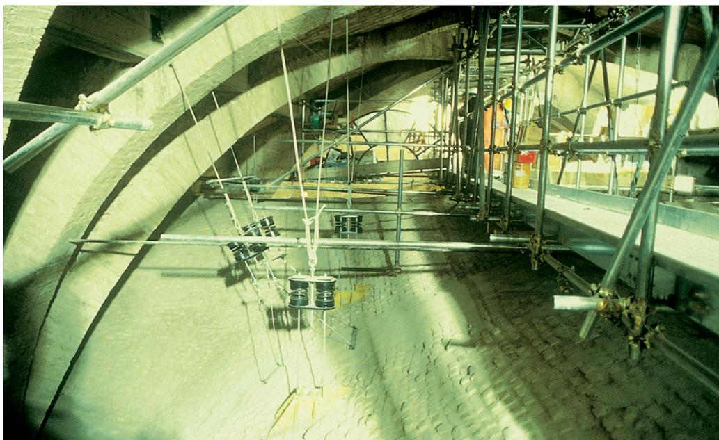
16. Recuperación de algunos ladrillos con frescos para ser utilizados de nuevo en la reconstrucción de las bóvedas
