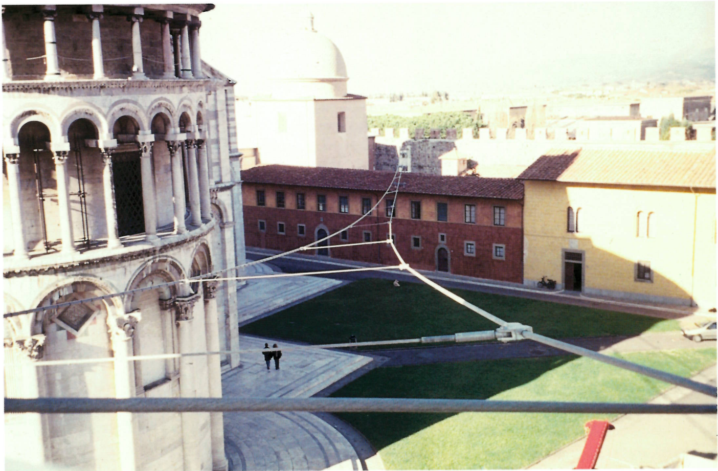
Cables provisionales aplicados a la Torre de Pisa
