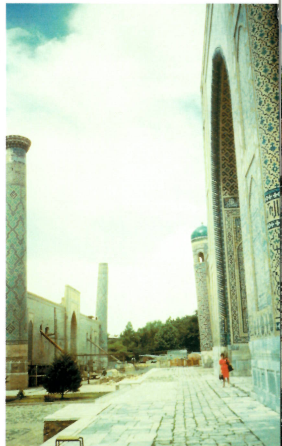
1. Asentamientos y deformaciones de los minaretes y monumentos en Samarcanda debidos al pasaje de agua en el terreno
