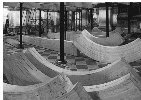
Fig. 42: Piezas de madera desmontadas en San Lorenzo, Venecia.
