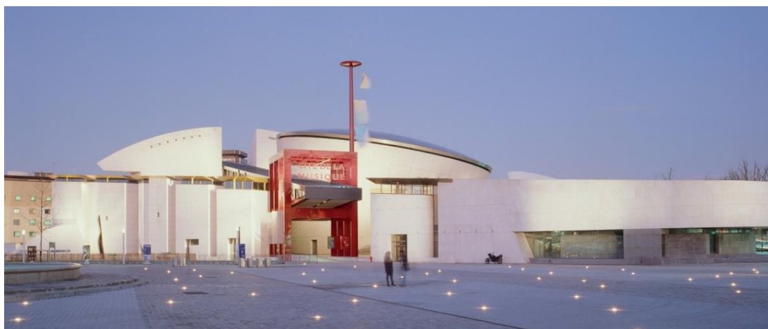
Fig. 48: Imagen exterior de la Cité de la Musique .
