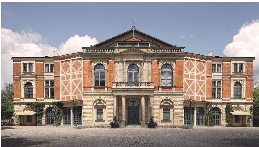
Fig. 9: Fachada principal actual del teatro.
