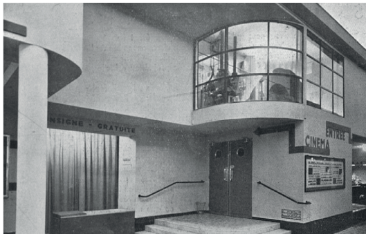
Figura 8. Interior de cabina de proyección de Cinéac Le Journal, Gare de Montparnasse, 1933, y exterior.
