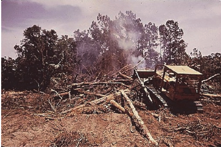
Figura 1.4. Concentración de residuos con buldócer
