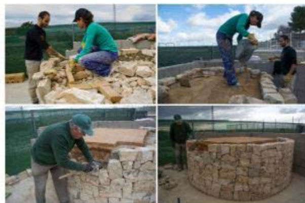
Imagen 81. Blog de Biodivers con comentarios sobre el avance de las obras durante su construcción: Traducción de la autora: «Vicent Bohigues rematando la base de piedra seca del horno de Pablo y Nuria, que ya tienen la primera fase con el suelo colocado» Fuente: fotografías de Altabert, 2015 https://biodivers2015.wordpress.com/2015/02/16/cap-de-setmana-a-tope/
