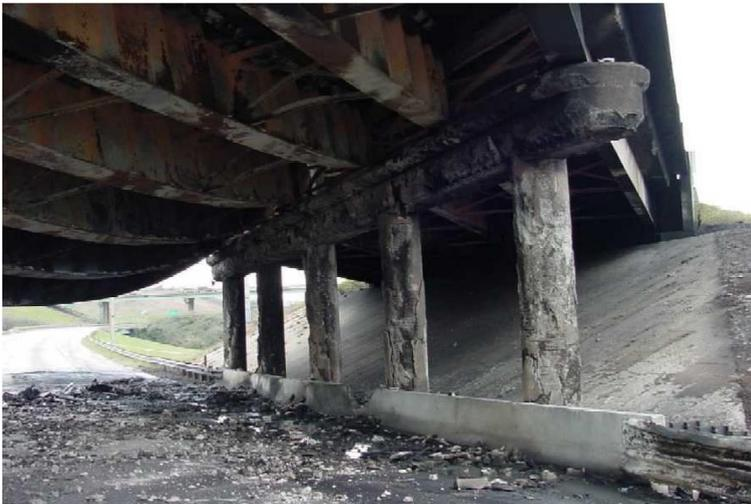
*Figura 3-5. Detalle de las pilas tras el incidente desde el lado Sur. Cortesía del ALDOT.*
