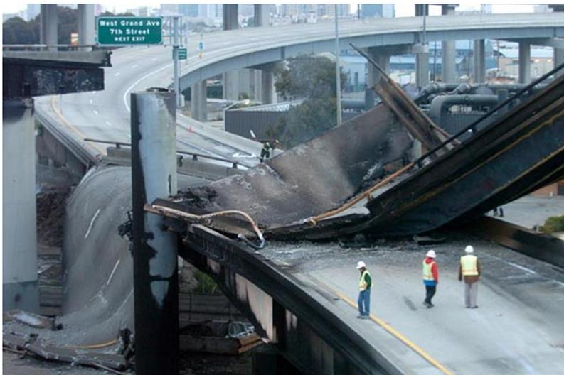
*Figura 2-11. Colapso del Intercambiador MacArthur Maze en Oakland, CA, USA. Fuente: Noah Berger.*
