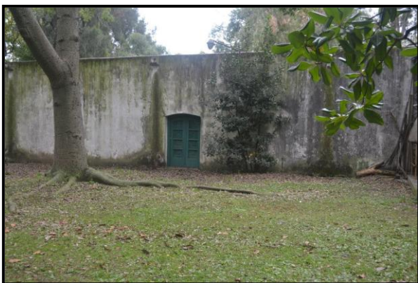
Figura 6. Contrafrente actual de la Casona. Nótese que la pared actualmente visible era una pared interior.
