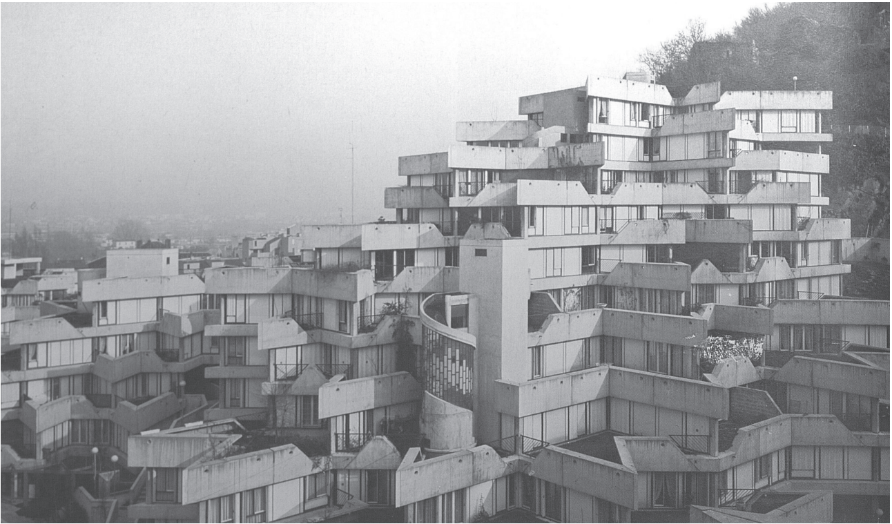
Figure 2. Les Étoiles de Givros (1974-1981). View in Patrice, Cornu, "La troisième dimension. Les étoiles de Renaudie, Givros, 1975-1981," L'Architecture d'aujourd'hui , no. 220 (April, 1982): 14 / Figura 2. Les Étoiles de Givros (1974-1981). Recogido en Patrice, Cornu, "La troisième dimension. Les étoiles de Renaudie, Givros, 1975-1981," L'Architecture d'aujourd'hui , no. 220 (Abril, 1982): 14.
