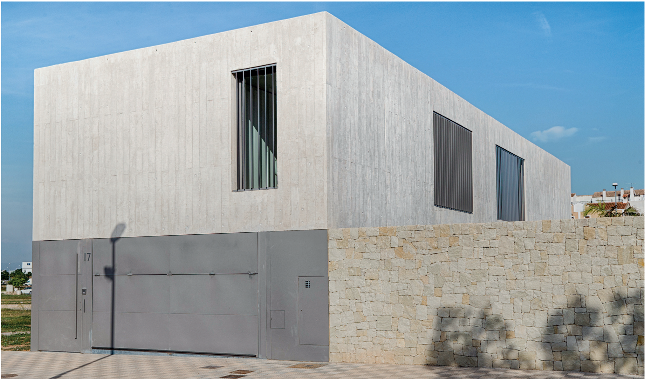
Figure 1. Access, southwest facade. 2019. ©Carlos Izquierdo / Figura 1. Acceso, fachada suroeste. 2019. ©Carlos Izquierdo.
