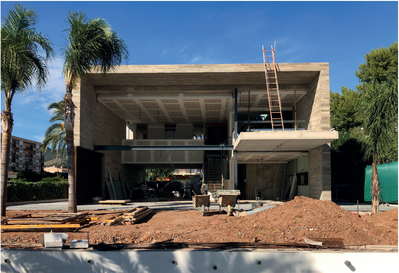
Figure 5. Southeast elevation, construction process. sanahuja&partners. 2019. ©Pablo Morán / Figura 5. Alzado sudeste, proceso de construcción. sanahuja&partners. 2019. ©Pablo Morán
