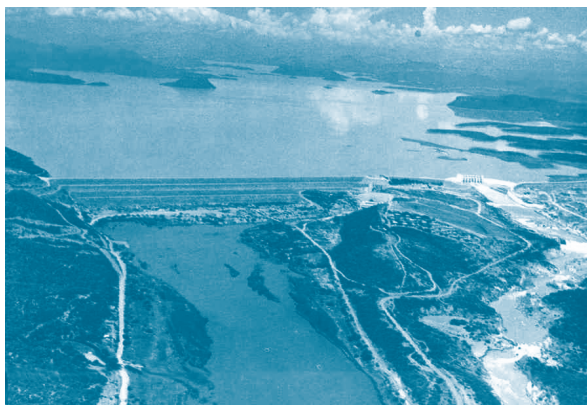
Fotografía 1. Presa Miguel Hidalgo, Sinaloa (1956). Cortina de materiales graduados de 81 m de altura y longitud de corona de 2905 m. Se sobreelevó en 1964. Vertedor de abanico, Hiriart (1949) al que se le añadió una zona con siete compuertas. La longitud de la cresta libre es de 346.9 m y la controlada con compuertas de 63 m. El caudal máximo del conjunto es de 16,450 m 3 /s. Se aprovecha para el riego de 240,000 ha. La capacidad instalada de la central hidroeléctrica es de 60 MW.
