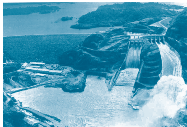
Fotografía 2. Presa Nezahualcóyotl, Chiapas (1964). Cortina de materiales graduados de 138 m de altura y longitud de corona de 478 m. Vertedores controlados con compuertas. El de servicio (más cercano a la cortina) tiene una longitud de 45 m y su caudal máximo es de 11,100 m 3 /s, y termina en un tanque amortiguador. El segundo vertedor es el de excedencias; su longitud es de 60 m, su caudal máximo de 10,650 m 3 /s y termina en un deflector. Se construyó inicialmente para control de avenidas; también se aprovecha para el riego de 350,000 ha y genera anualmente 2754 GWh.
