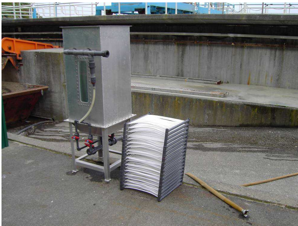
Figura 1. Tanque del reactor (izda.) y módulo de membranas tubulares antes del montaje (dcha.)
