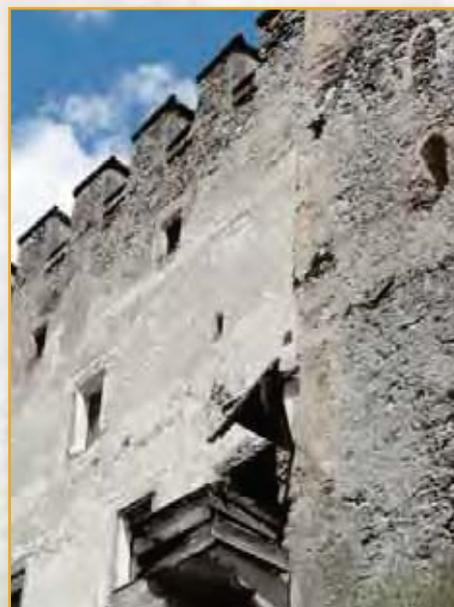
esta “esquina”, se observa una línea de fractura; en cambio, en la parte alta esa fractura no se encuentra en línea con lo de abajo, sino desplazada al oeste (para explicar esta situación se ha realizado un esquema).
