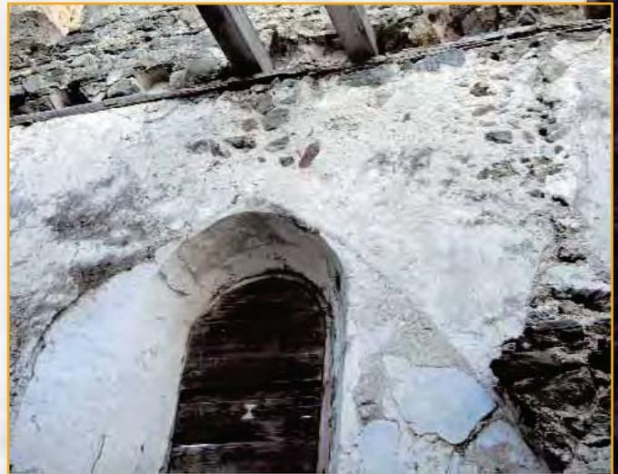
Muy importante fue analizar por el exterior la capa del enfoscado que recorre toda la fachada (US 21), ya que el estudio de los diferentes estados de degradación ha permitido identificar después en el frente sur la extensión de la elevación del muro (US 15), sin duda la parte más degradada.
