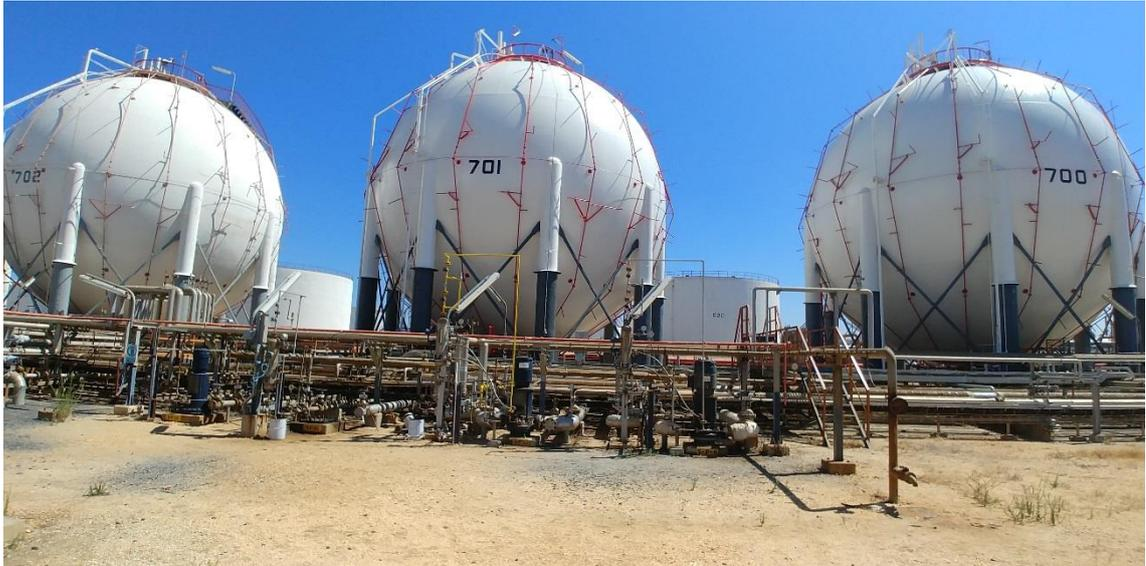
Figura 17. Depósitos GLP en Refinería. Fuente: Cliente.
