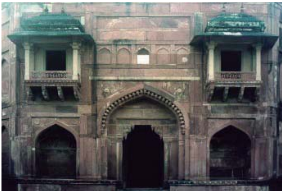
Edificio de Fatehpur Sikri.
