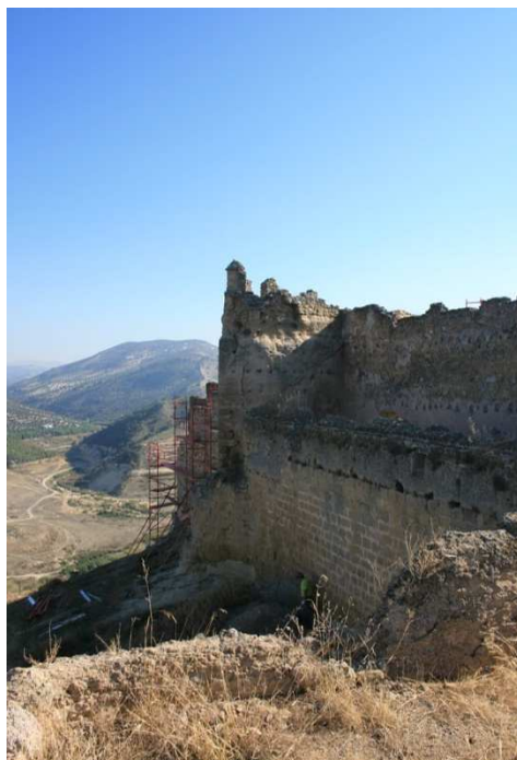
Fig. 8. Vista exterior del antemuro y de la torre pentagonal.
