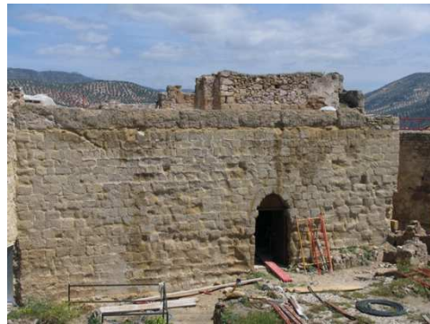
Fig. 4. Vista general del edificio, con puerta de acceso y remate con peto de tapial.
