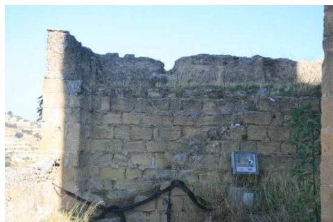
Fig. 7. Detalle del antemuro, paramento interior, en el sector 2.
