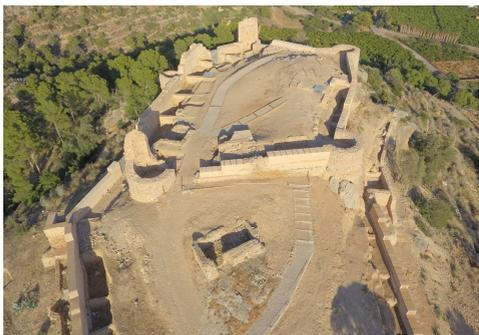
Fig. 8. Vista final después de la intervención. Se observa el circuito de visita que aprovecha estructuras de intervenciones anteriores (Autor, 2018).
