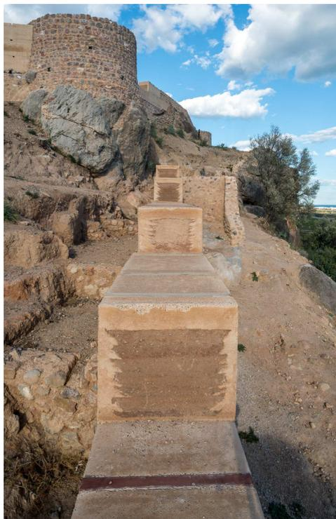
Fig. 3. Fábricas de tapial de tierra calicostrada en consolidación de muro existente (Autor, 2017).
