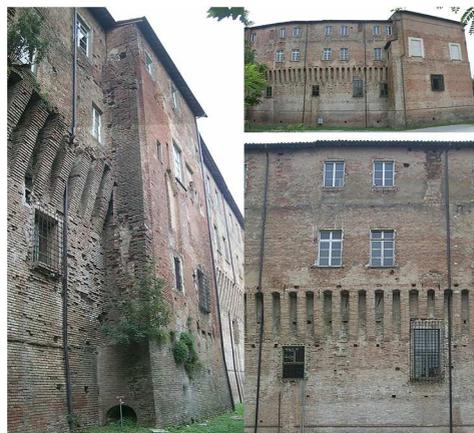
Fig. 5. Viste del fronte nord della rocca da cui se ne evince la natura stratificata: a sinistra la torre centrale con le tracce del ponte levatoio; a destra, vista e dettaglio del settore-torre n-o, in cui sono riconoscibili i resti dei merli ghibellini iniziali, al primo livello.
