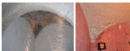
Fig. 8. (Izquierda) Bóveda del aljibe del Castillo de Santa Catalina en Jaén (fotografía de Francisco Javier Merino Laguna). (Derecha) Bóveda del aljibe del Castillo de Alcaudete, en este caso con una disposición circular de las rosas de los ladrillos.
