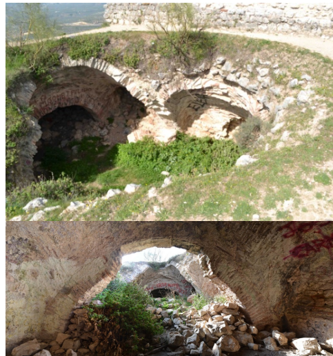
Fig. 5. Vista del aljibe desde la parte superior y desde el interior de la nave más oriental. Todo el interior se encontraría revestido con un enfoscado de cal para impermeabilizar, que cuenta también con restos de pintura a la almagra.
