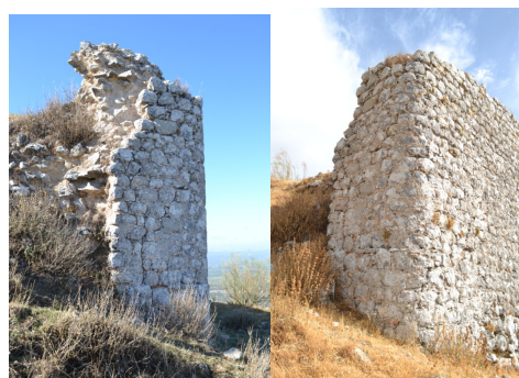
Fig. 6. Detalles de la esquina curvada en el extremo norte del lienzo L6, vista desde el alzado norte y desde la esquina noroeste respectivamente.
