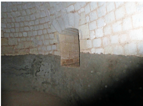
Fig. 3. Arranque de la cúpula del torreón, planta baja.
