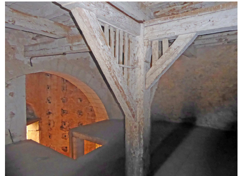
Fig. 4. Soporte de madera de la torre sur, planta baja.
