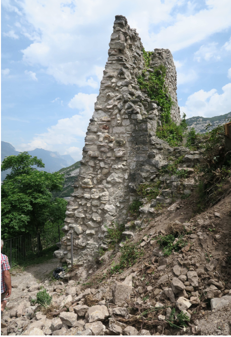
Fig. 5. CF II, prospetto sud interno inizio lavori (05.2019).
