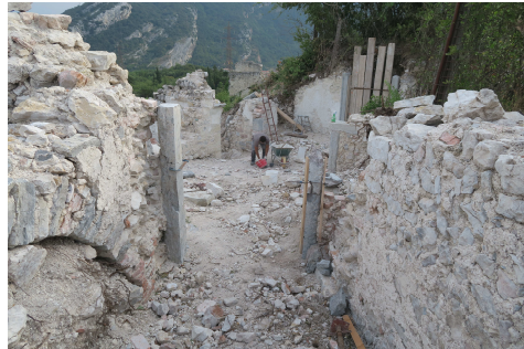
Fig. 8. Vista dell' UF 5 da CF II durante i lavori.
