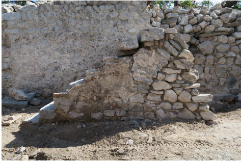
Fig. 9. CF II UF 7, scala in pietra su arco rampante.
