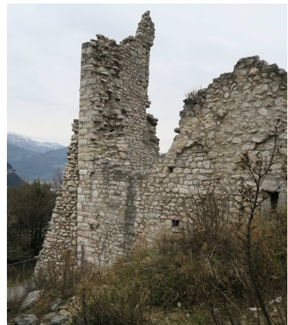
Fig. 4. CF II UF3, prospetto sud esterno (02/2018).
