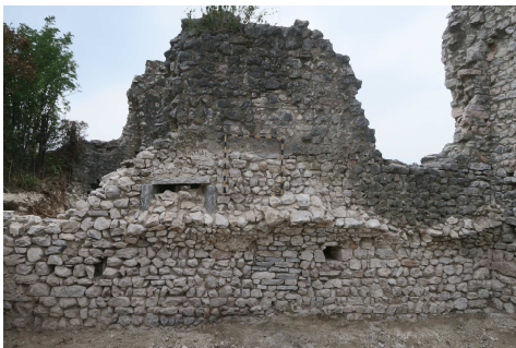
Fig. 10. CF II UF 3, prospetto interno sud dopo la rimozione.
