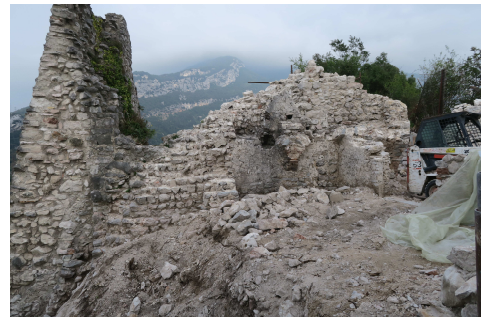
Fig. 11. CF II UF 7, scala in pietra su arco rampante.
