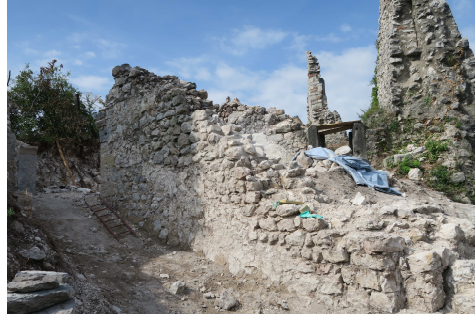
Fig. 6. CF IV UF 4, prospetto sud ingresso (08/2019).
