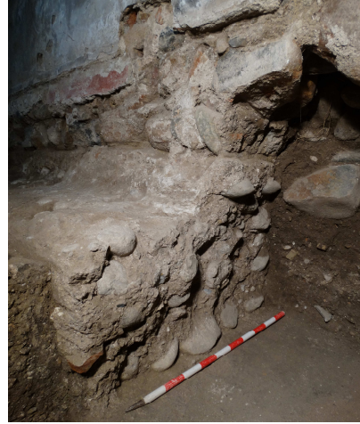
Fig. 5. Rotura de la muralla identificada como la coracha.
