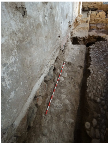
Fig. 2 Muralla identificada con la coracha sobre la que se apoya parcialmente el muro perimetral este del Maristán.
