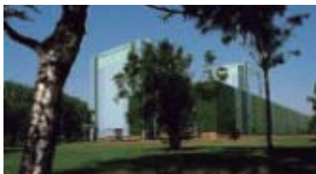
2 y 3. Industria ThyssenKrupp AG Feuerbeschichtungsanlage FBA 8. Friedrich Ernst von Garnier Studio, Dortmund (Alemania), 2003. Vista General (www.studiovongarnier.de)
