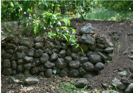
Muro de piedra
