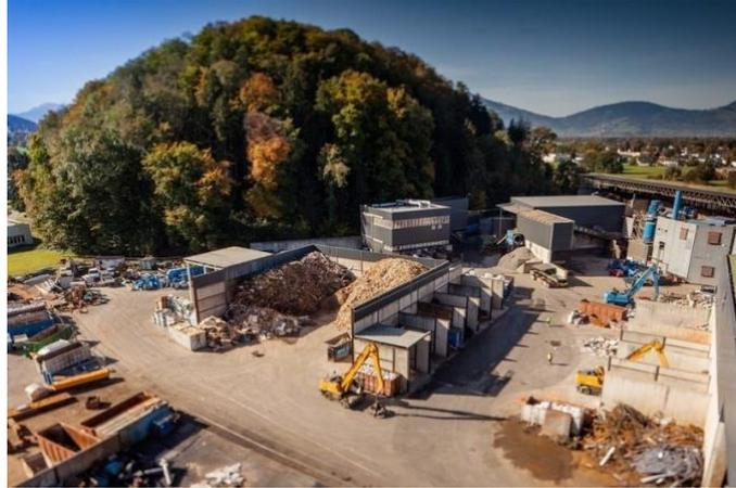
*Ilustración 1. Patio de recepción y almacenamiento de una planta de residuos.*
