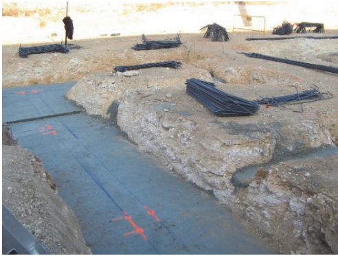
Figura 23. Replanteo sobre hormigón de limpieza. Imagen: V. Yepes
