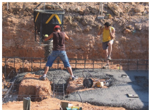
Figura 28. Hormigonado con cubilote. Fuente: http://emetresemestudio.blogspot.com.es/
