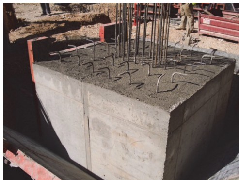
Figura 32. Desencofrado. Imagen: I. Serrano ( www.desdeelmurete.com )
