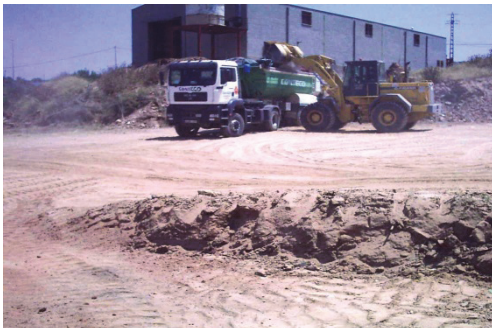
Figura 15. Limpieza y desbroce del solar. Imagen: V. Yepes
