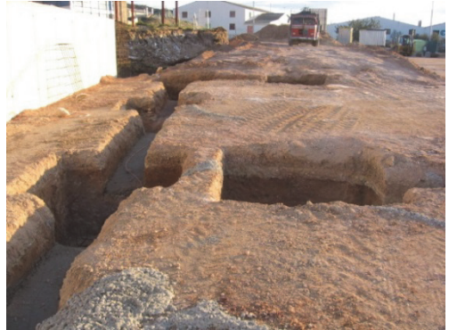
Figura 18. Excavación hasta la cota superior del cimiento. Imagen: V. Yepes
