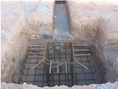
Figura 25. Colocación de armadura. Imagen: V. Yepes
