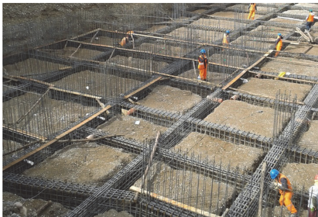
Figura 51. Emparrillado de cimentación.
