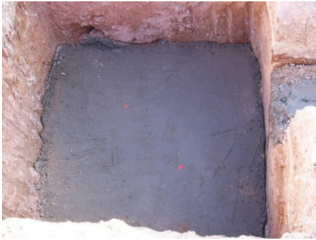
Figura 19. Hormigón de limpieza. Imagen: V. Yepes
