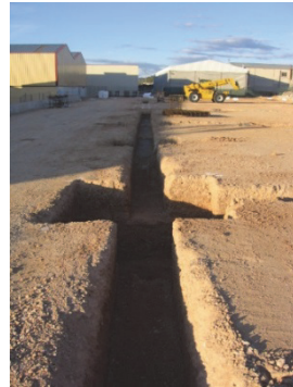
Figura 20. Excavación hasta la cota superior del cimiento. Imagen: V. Yepes
