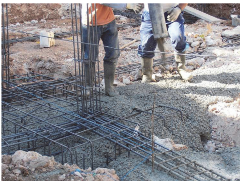
Figura 27. Hormigonado con tubo. Fuente: arq.clarin.com
