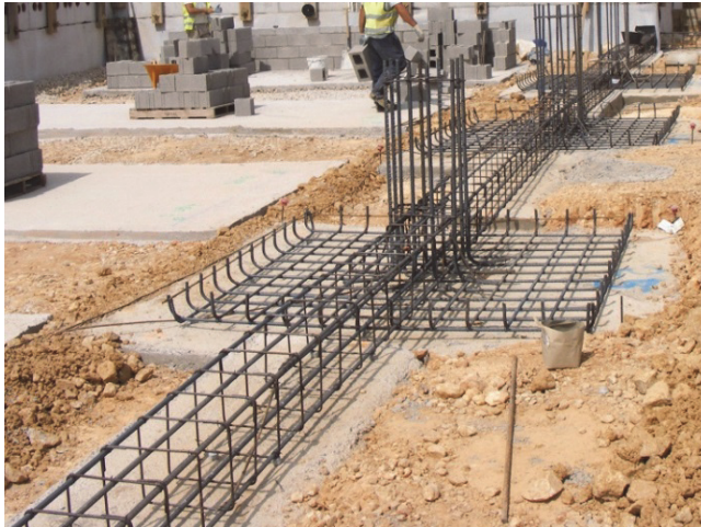
Figura 49. Detalle de armado de zapatas arriostradas. Imagen: E. Valiente
