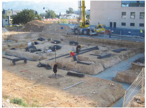
Figura 24. Colocación de armadura. Imagen: V. Yepes
