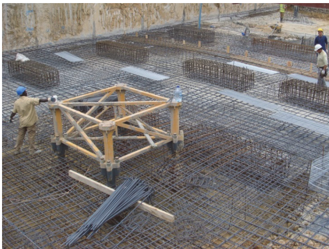
Figura 55. Detalle del armado de una losa de cimentación.
