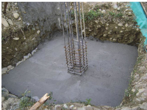
Figura 31. Curado del hormigón. Fuente: http://construtoraindustrialyminas.com/
