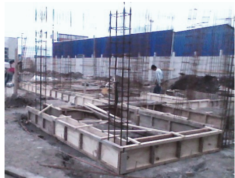
Figura 22. Encofrado de zapatas. Fuente: http://constructorinmobiliario.blogspot.com.es/
