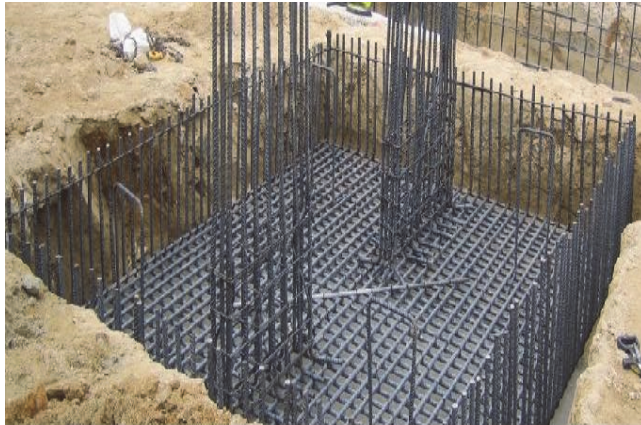
Figura 37. Zapata combinada. Fase de preparación de parrilla superior.
