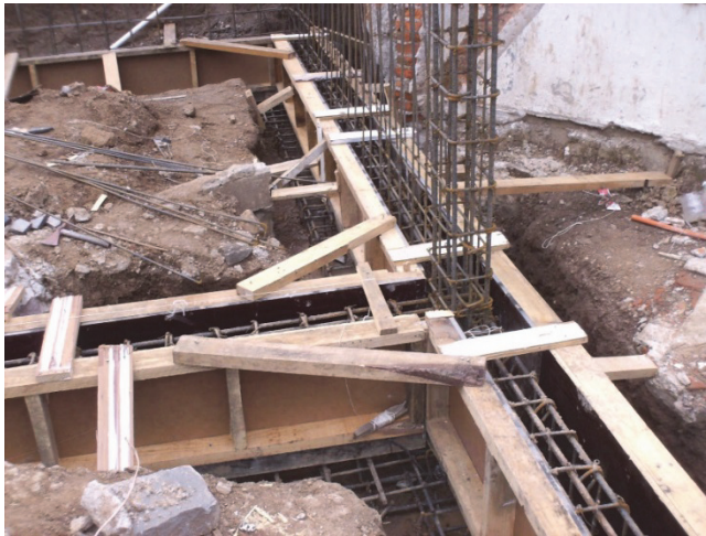
Figura 40. Detalle de encofrado en zapata continua bajo pilares. Fuente: http://todoarquitecturadisenoconstruccion.blogspot.com.es/
