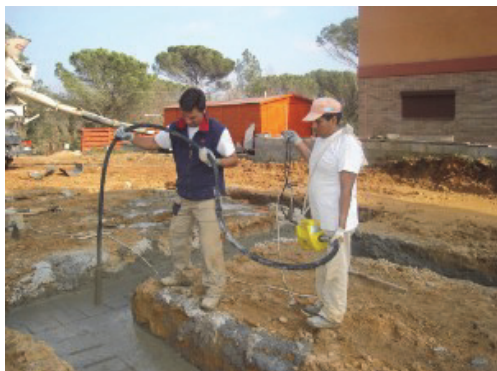
Figura 29. Vibrado del hormigón. Fuente: http://www.newjoquesa.net/
