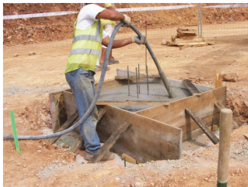
Figura 30. Vibrado del hormigón. Imagen: E. Valiente
