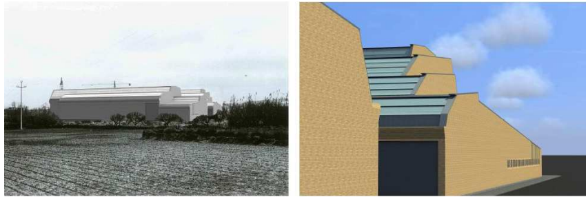
Fig. 27. R. Moneo. Fábrica Diestre, 1964, reconstrucción digital.
