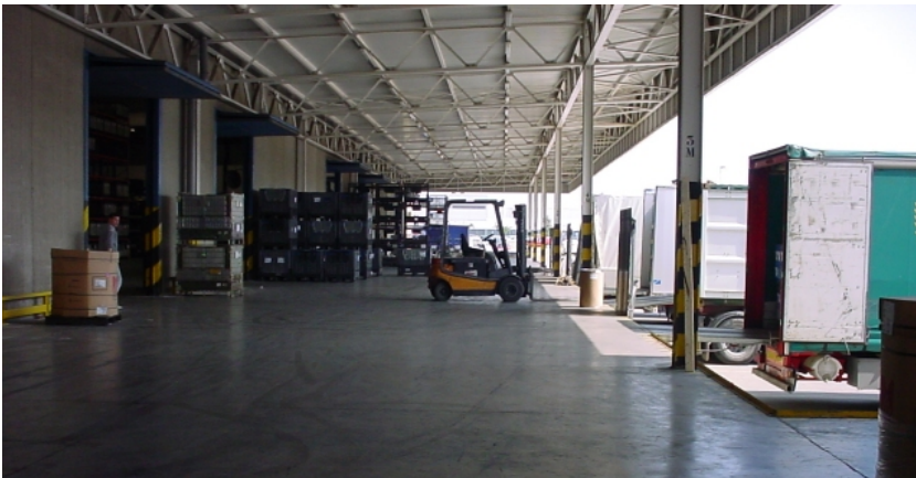
Figura 2.5: Muelle de un centro de consolidación logística.
