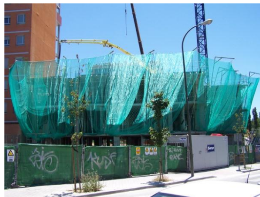
Fig. 3.18 Proceso constructivo día "16" (forjado de losa maciza)
