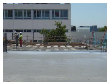
Fig. 3.88 Proceso constructivo día “17” (forjado reticular de casetón recuperable)
