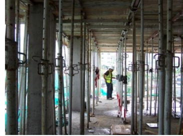
Fig. 3.16 Proceso constructivo día "10" (forjado de losa maciza)
