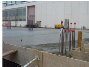
Fig. 3.86 Proceso constructivo día “0” (forjado reticular de casetón recuperable)
