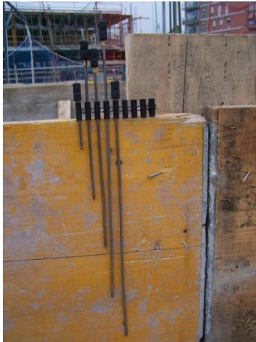
Fig. 3.53. Termopares embebidos en el hormigón en la zona del ábaco (forjado reticular de casetón perdido).
