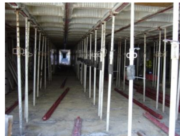
Fig. 3.87 Proceso constructivo día “7” (forjado reticular de casetón recuperable)
