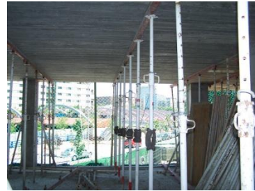
Fig. 3.17 Proceso constructivo día "15" (forjado de losa maciza)
