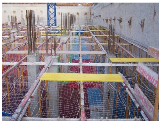
Fig. 3.1 Sistema Alumecono (edificio de Sabadell)
