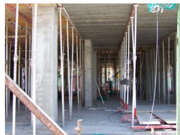
Fig. 3.15 Proceso constructivo día “7” (forjado de losa maciza)
