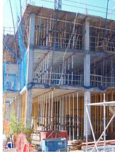
Fig. 3.63 Proceso constructivo día “137” (forjado reticular de casetón perdido)
