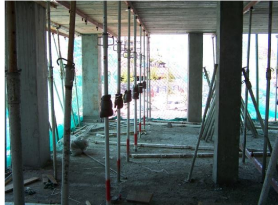
Fig. 3.19 Proceso constructivo día "22" (forjado de losa maciza)
