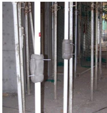
Fig. 3.7 Protección utilizada para las bandas extensométricas
