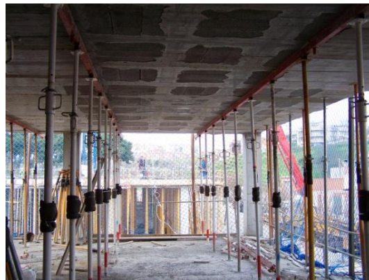
Fig. 3.62 Proceso constructivo día “115” (forjado reticular de casetón perdido)
