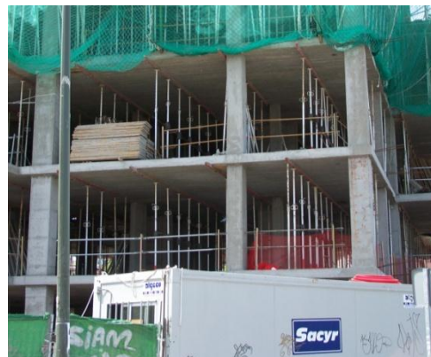
Fig. 3.20 Proceso constructivo día "23 a" (forjado de losa maciza)
