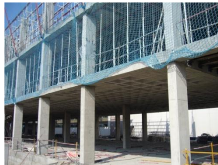
Fig. 3.93 Proceso constructivo día “38” (forjado reticular de casetón recuperable)
