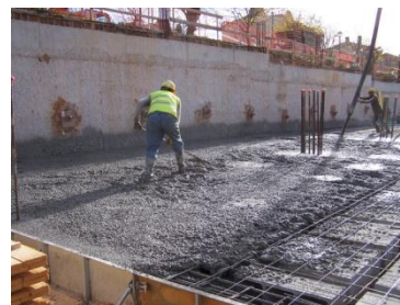
Fig. 3.54 Proceso constructivo día “0” (forjado reticular de casetón perdido)
