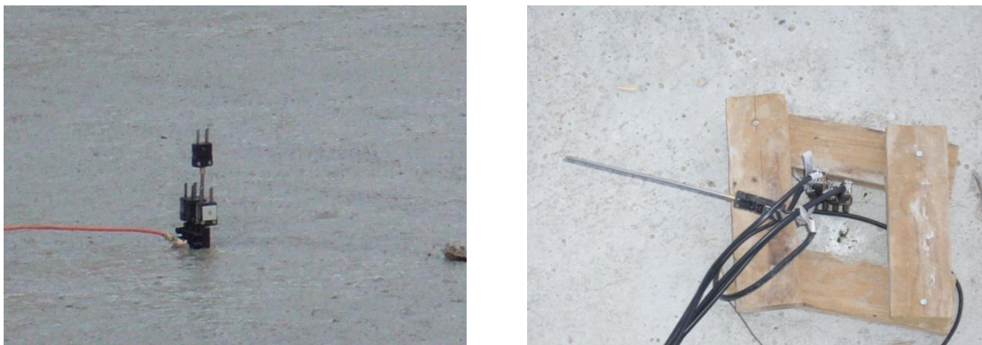
Fig. 3.85 Termopares embebidos en el hormigón (forjado reticular de casetón recuperable)
