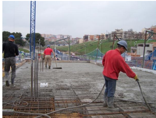
Fig. 3.61 Proceso constructivo día “111 b” (forjado reticular de casetón perdido)
