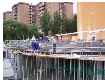
Fig. 3.14 Proceso constructivo día “0” (forjado de losa maciza)
