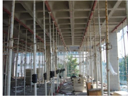
Fig. 3.92 Proceso constructivo día “37” (forjado reticular de casetón recuperable)
