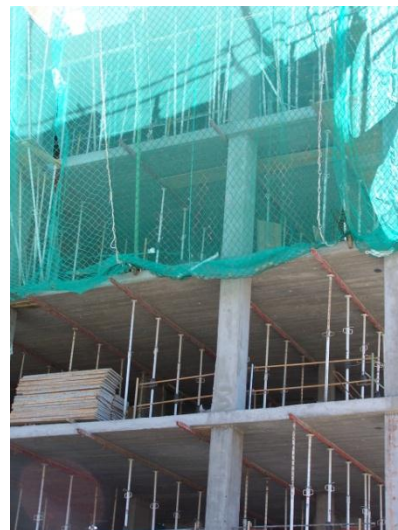
Fig. 3.22 Proceso constructivo día “28” (forjado de losa maciza)
