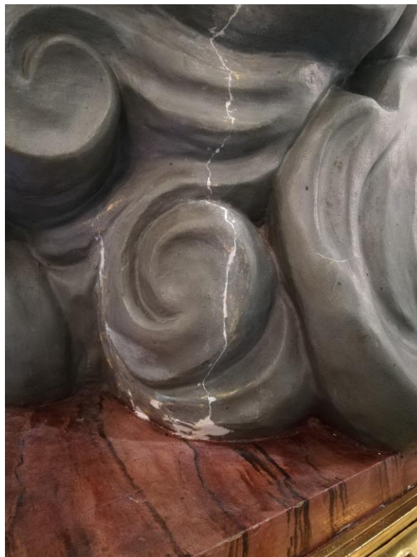
Figura 6. Estucado de grietas
