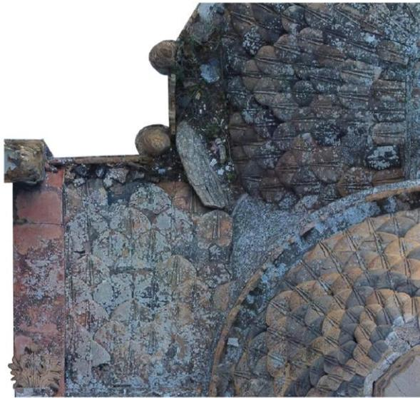
**Particular de la cubierta, ortoimagen del modelo:** además del dibujo geométrico formado por la tejas de colores diferentes, se puede notar un trozo del ala que supuestamente pertenecía a la estatua de ángel que antiguamente coronaba la cúpula.
