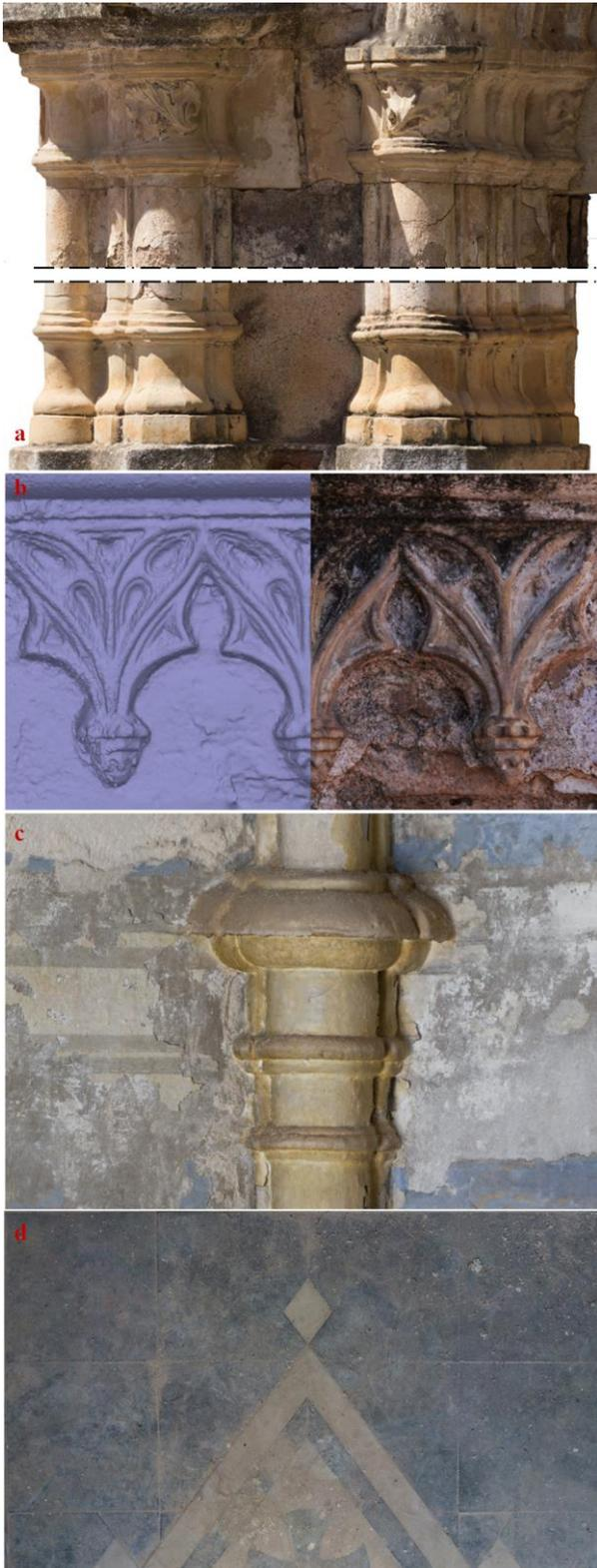
Figura 12. Ortoimágenes extraídas a partir de modelos de detalle de elementos: a) base y capitel exteriores; b) *mesh* y textura de la decoración exterior; c) capitel interior; d) suelo interior
