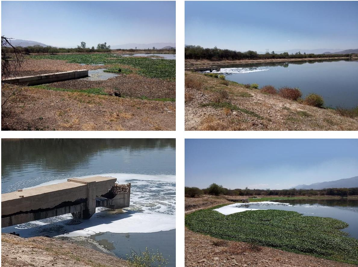
**Figura 5.3.** De arriba abajo y de izquierda a derecha. a) Laguna anaeróbica nº 1. b) Laguna anaeróbica nº 2. c) Entrada a la laguna anaeróbica nº 2. d) Laguna facultativa. Fuente: elaboración propia
