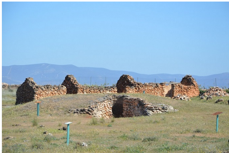
Fig. 3 Calera en el paraje las Salinas
