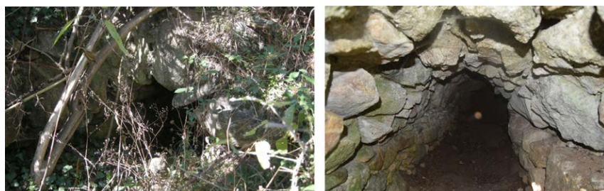
Fig. 5 Vistas exterior e interior del socaz
