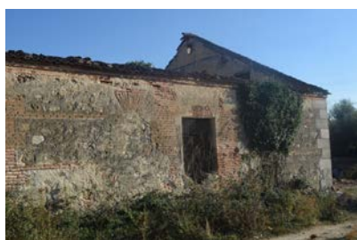
Fig. 4 Fachada norte del edificio
