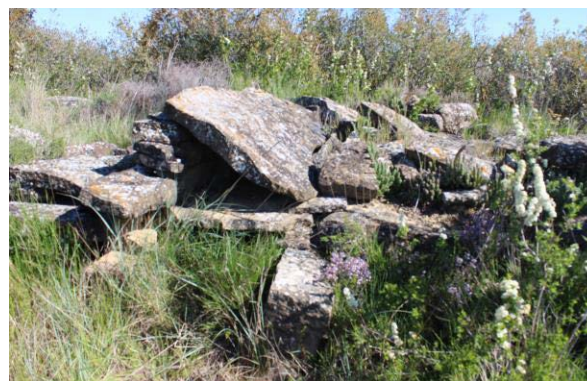
Fig. 8 Ventureros totalmente derruidos
