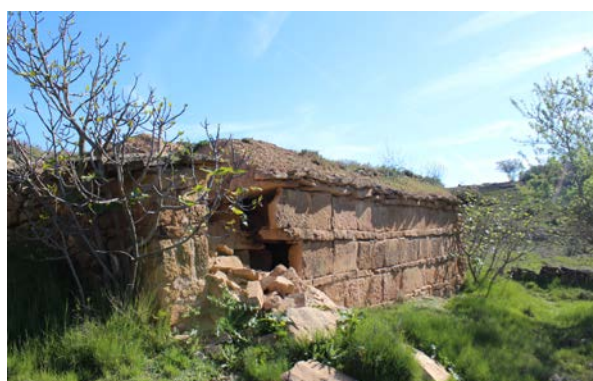
Fig. 7 Bejera parcialmente destruida
