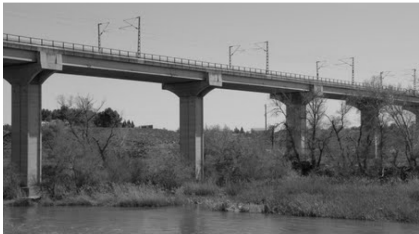
Figura 4.2. Viaducto del Tajo, (línea AV Madrid-Sevilla), constituido por 17 vanos isostáticos
