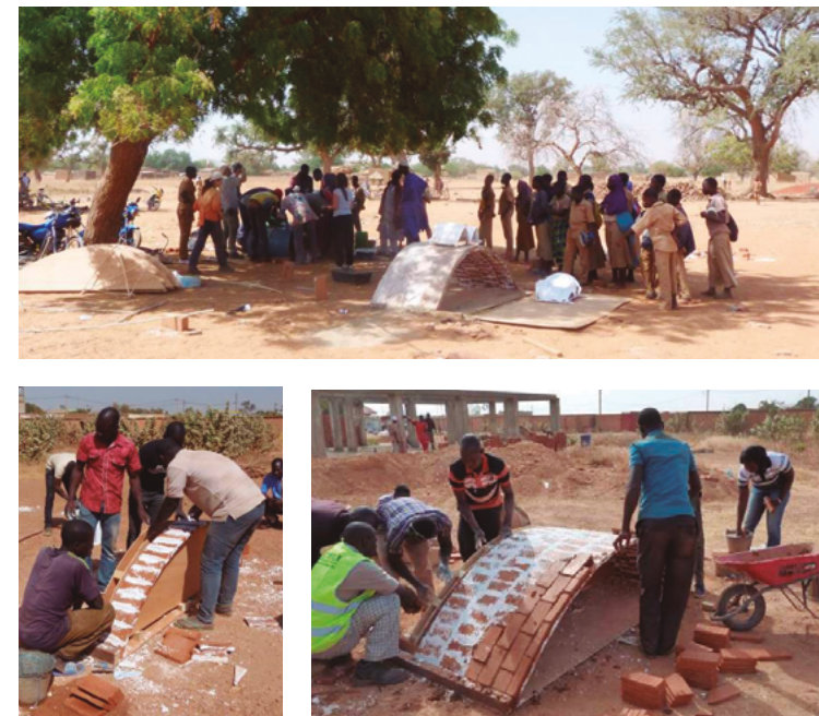
Imagen 5. Talleres de formación para la construcción de bóvedas tabicadas con BTC. Fuente. Elaboración propia.
