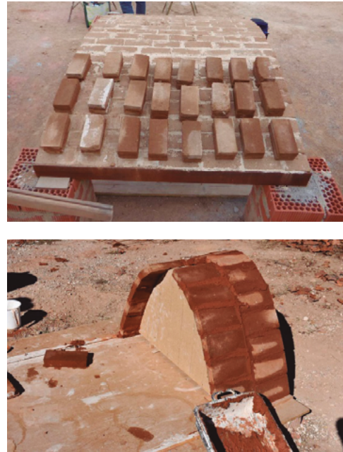
Imagen 4. Pruebas de materiales (BTC y mortero de tierra) para la construcción de bóvedas tabicadas desarrolladas en la UPV. Fuente. Elaboración propia.
