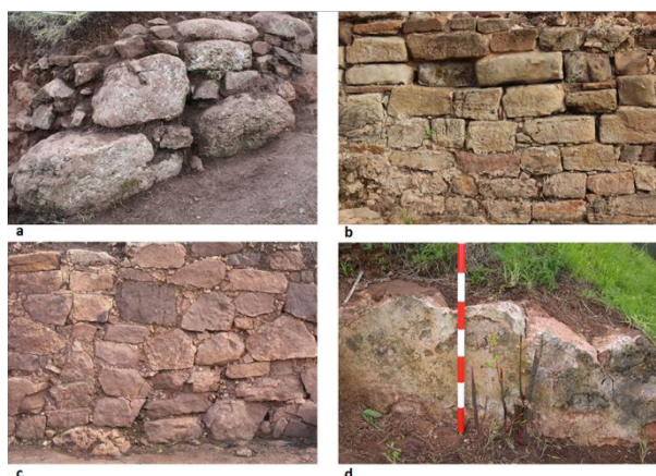
Figura 9: Detalle de algunos de los aparejos constructivos empleados en el castillo: a) cimentación de la torre norte; b) paramento meridional de la torre sur; c) paramento del recinto amurallado superior en la zona del callejón; d) paramento oriental de la iglesia.
