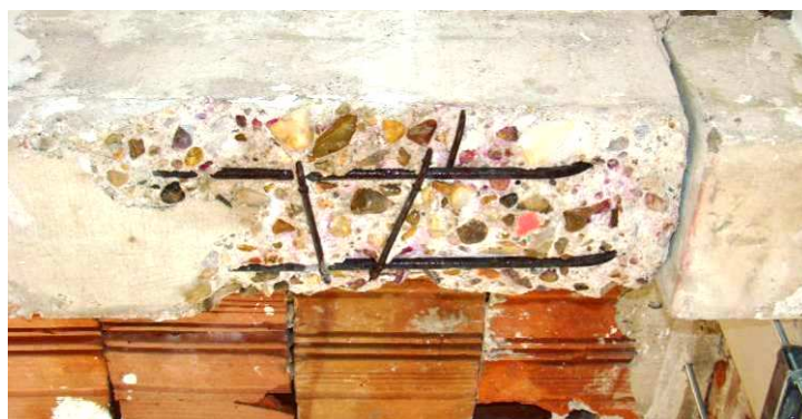
Figura IV. 87. Cata en viga, Edificio, 1959. (INTEMAC).
