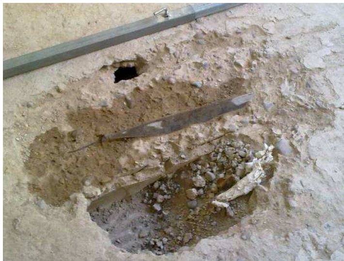
Figura IV. 83. Piqueta para el armado de negativos en forjado. Edificio 104C.006, 1942
