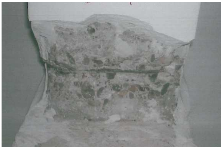
Figura IV. 88. Cata en pilar, edificio ficha 84C.017, 1959.
