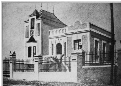
Figura I. 45. Villa construida con elementos estructurales de hormig n armado en la Cruz del Campo (Sevilla), 1908-1914. Juan Ram n Sena, ingeniero Militar.
