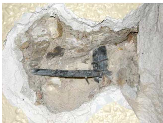
Figura IV. 143. Cala en pilar. Edificio ficha 94C.023, 1966.
