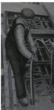
Figura II. 29 Ilustración de compactación con vibrador. (Vilagut, 1931).
