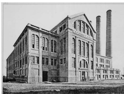
Figura I. 40. Central eléctrica de San Adrián del Besos. Construcciones y Pavimentos, 1910-1920
