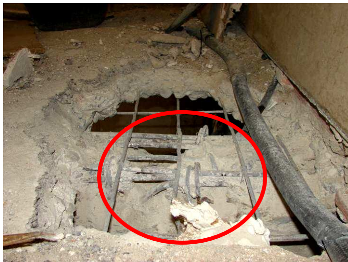
Figura IV. 150. Detalle de anclaje de barras (INTEMAC, 1968 (08117))
