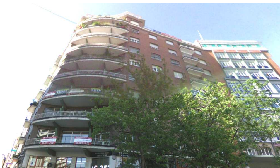
Fotografía IV. 1. Edificio esquina C/ Xativa con C/Colón. 1964.
