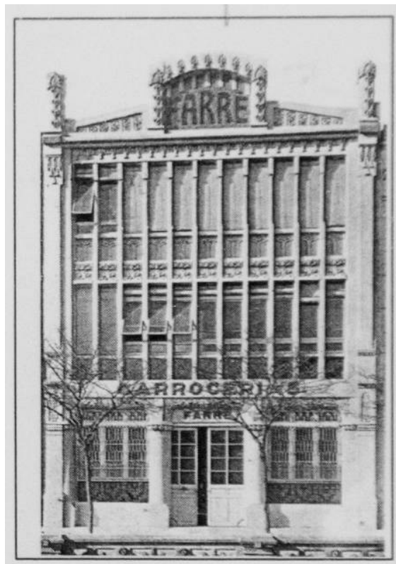
Figura I. 42. Talleres de Carrocerías Farré. Barcelona 1910. Construcciones y Pavimentos, con patente Hennebique.
