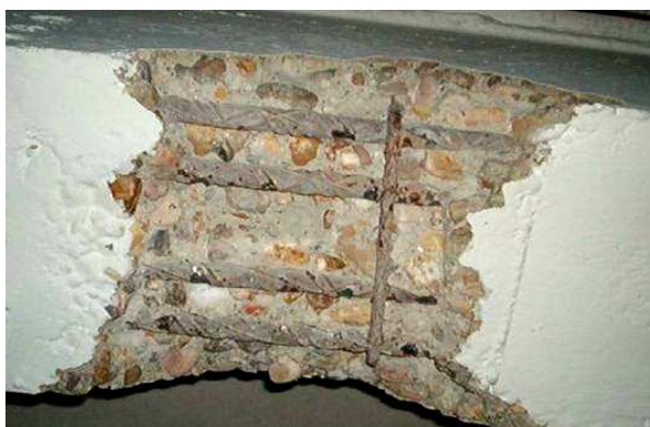
Figura IV. 154. Cala en jácena de hormigón con acero trenzado, INTEMAC, 1963 (03071)
