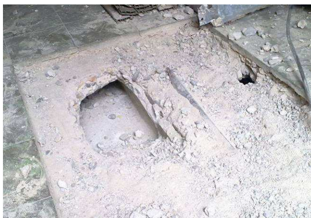
Figura IV. 26. Cala forjado con bovedilla de yeso y nervios in situ con piquetas de armado. Edificio 104C.006, 1952.
