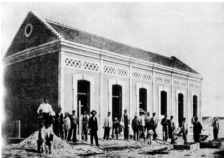
Figura I. 25 El pabellón de retretes del Cuartel de Artillería de Getafe, Madrid, 1902.
