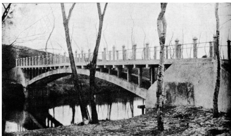
Figura I. 32. Puente sobre le río Henares en Soto de la Ciudad. Madrid (Martínez, 1903).
