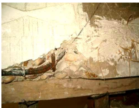
Figura IV. 136. Cala practicada en la cara inferior de la viga, en la posición de la fisura de mayor abertura, INTEMAC, 1965.
