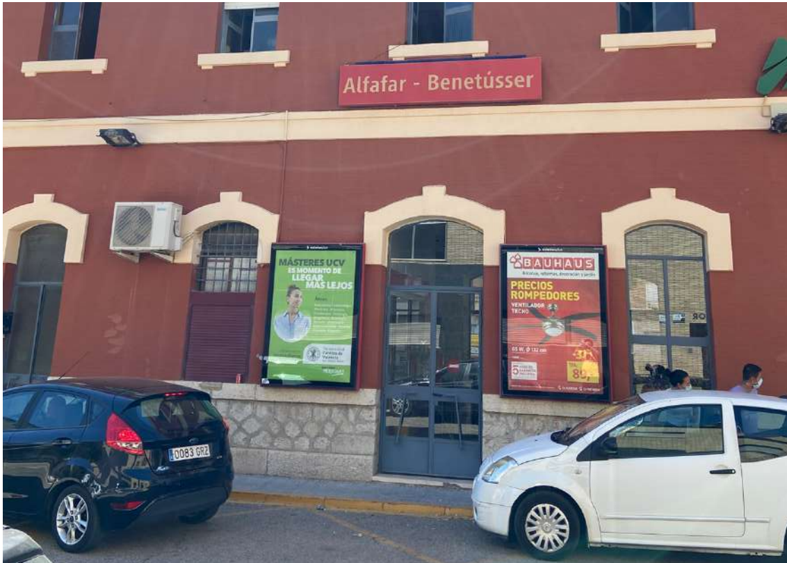
Imagen 8. Estación de cercanías Alfafar Benetússer. Fuente: Elaboración propia.
