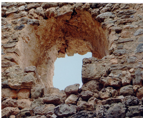
Fig. 250. Detalle del vano de la torre de Piqueras, capialzado y telares con derrame (Ruiz Checa)
