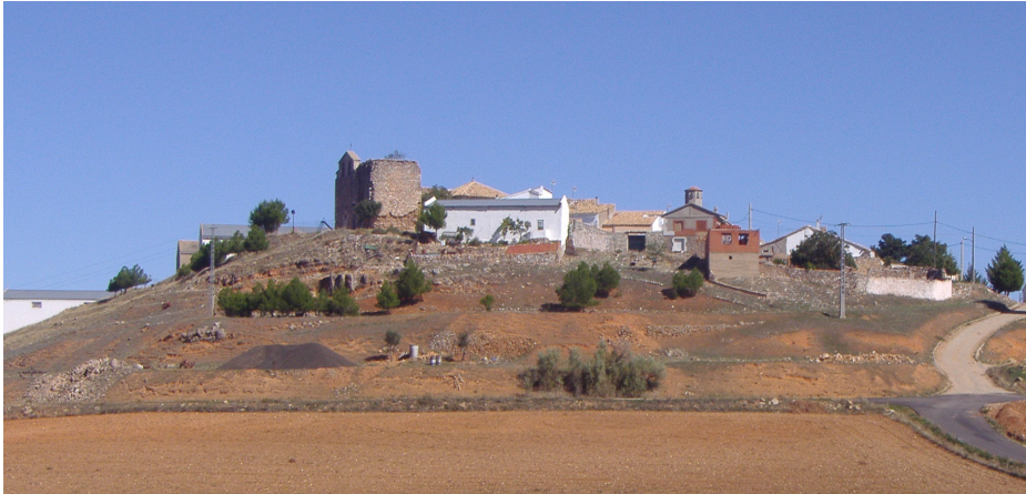
Fig.184. Foto de emplazamiento, torre de Chumillas (Ruiz Checa)
