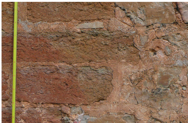
Fig. 243. Detalle de rejuntados en la Torre Barrachina (Ruiz Checa)
