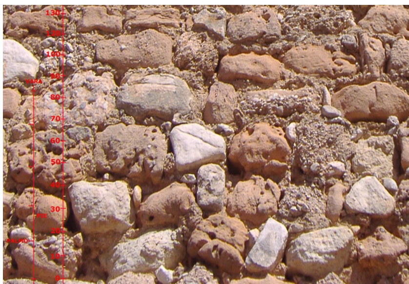
Fig. 240. Detalle de fábricas y modulación (m/vara), Torre de Chumillas (Ruiz Checa)
