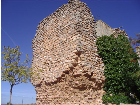
Vista torre de Chumillas
