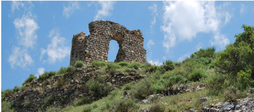
Fig.199. Foto de emplazamiento, torre de Alcalá (Ruiz Checa)
