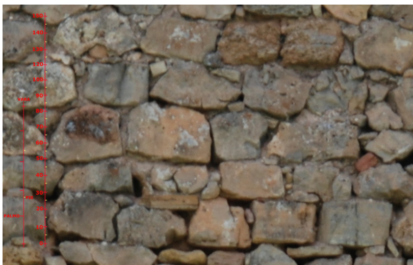
Fig. 238. Detalle de fábricas y modulación (m/vara), Torre Barrachina (Ruiz Checa)
