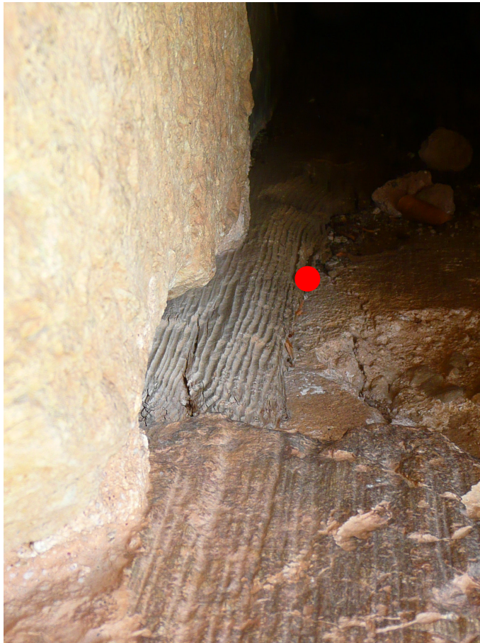
Detalle del punto de extracción de la muestra de madera: tabla del alamud en el acceso de la torre Barrachina (Villar del Humo- Cuenca)
