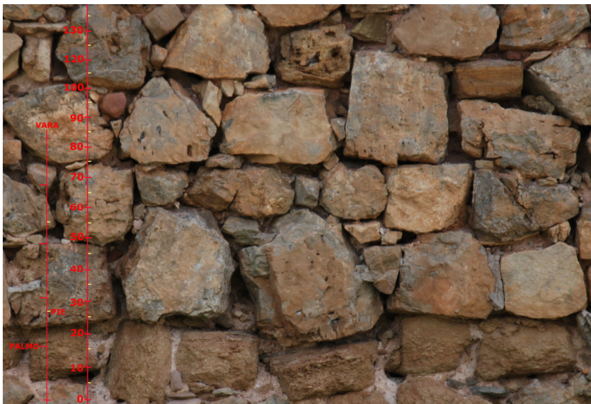
Fig. 236. Detalle de fábricas y modulación (m/vara), Torre de Alcalá de la Vega (Ruiz Checa)
