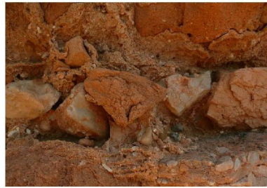
presencia de vegetación
