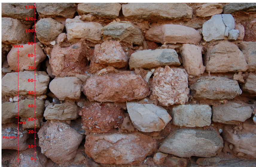
Fig. 242. Detalle de fábricas y modulación (m/vara), Torre de Valhermoso (Ruiz Checa)
