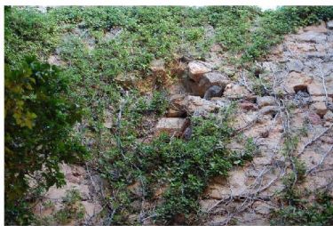
presencia de vegetación
