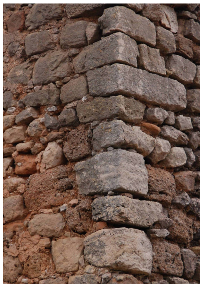
Fig. 246. Detalle de las esquinas de la Torre de Piqueras y de Valhermoso (Ruiz Checa)
