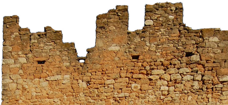
Fig. 258. Fotoplano de las almenas y merlones de la Torre de Piqueras y de las huellas de almojayas. (Ruiz Checa)
