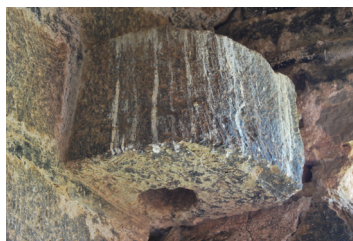
Fig. 253. Detalle de las rangas del vano de acceso de la torre Barrachina (Ruiz Checa)
