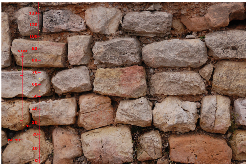
Fig. 241. Detalle de fábricas y modulación (m/vara), Torre de Solera (Ruiz Checa)
