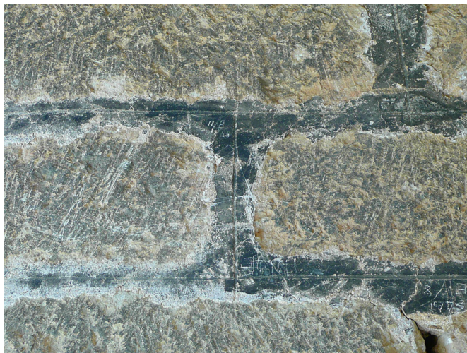
Fig. 244. Detalle de rejuntados en el vano de acceso a la Torre Barrachina (Ruiz Checa)
