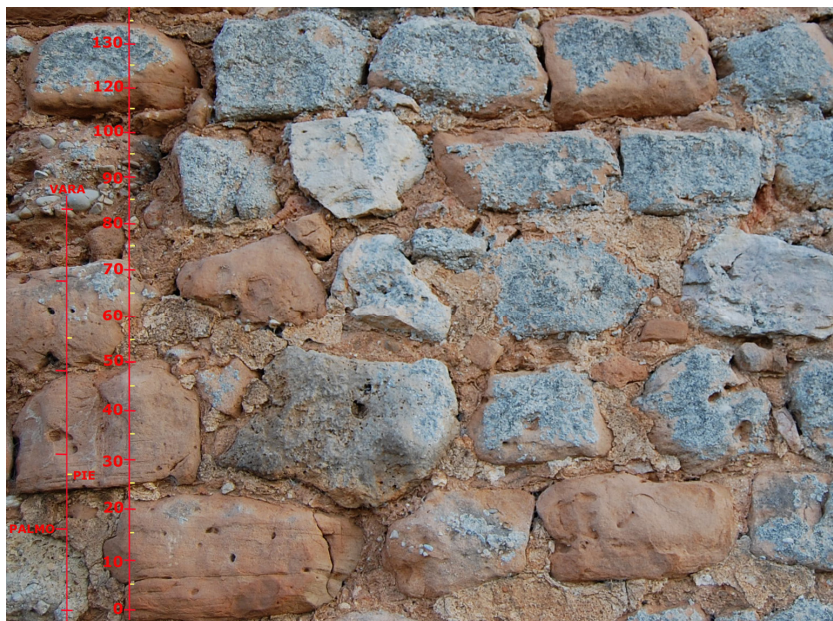
Fig. 239. Detalle de fábricas y modulación (m/vara), Torre de Piqueras (Ruiz Checa)
