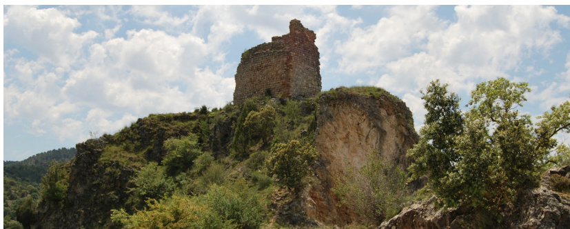
Fig.198. Foto de emplazamiento, torre de Alcalá (Ruiz Checa)
