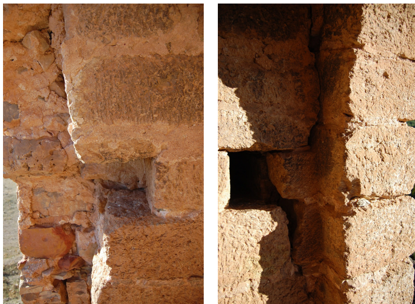
Fig. 256. Detalle del alamud de la torre de Barrachina (Ruiz Checa)
