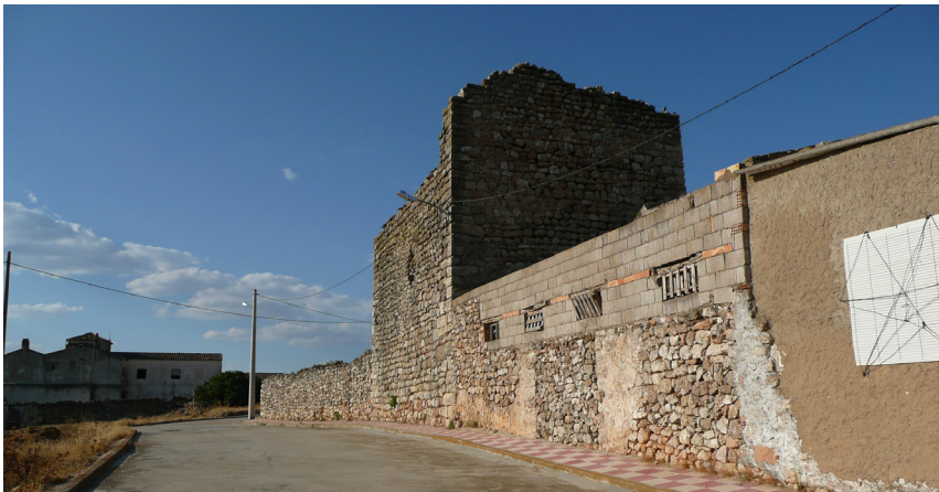
Fig.168. Foto de emplazamiento, torre de Solera, (Ruiz Checa)
