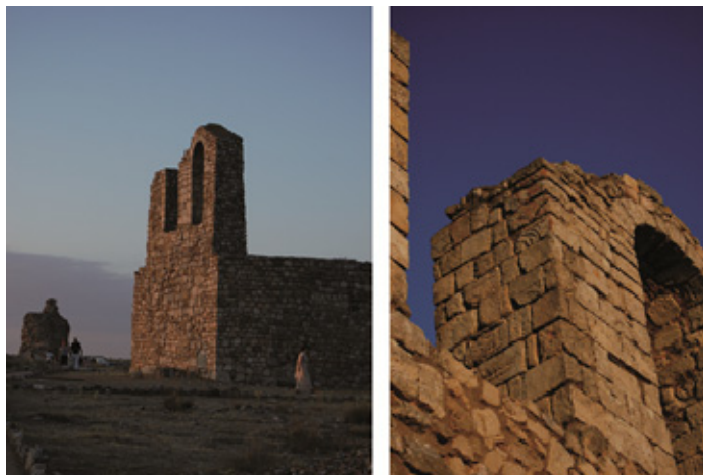
Fig.71. Arquitectura románica en el ámbito de estudio: Iglesia románica de Santa Catalina en Valeria, detalle de la reutilización de sillares romanos (Ruiz Checa)
