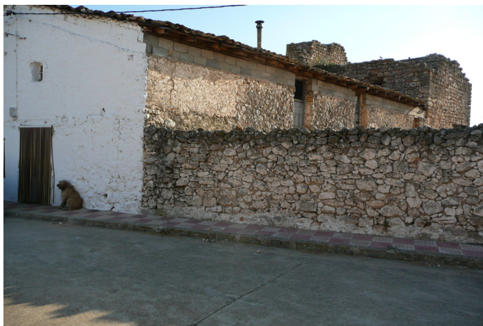
Fig.169. Foto de emplazamiento, torre de Solera, (Ruiz Checa)
