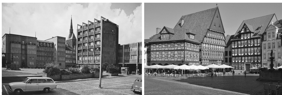
Figura 3. Hildesheim: Hotel Rose; Knochenhaueramtshaus (reconstruït)
