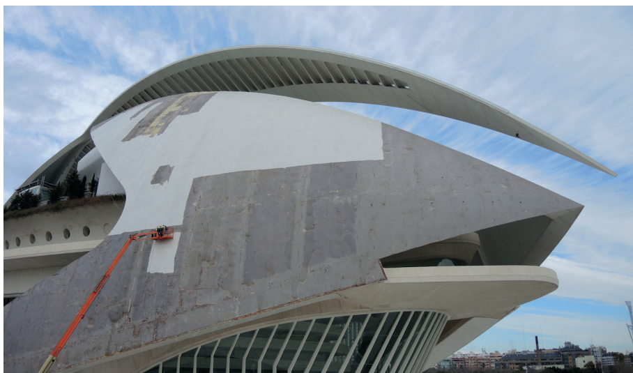
Palau de les Arts - obras de reparación, 2014. Foto: García Poveda.
