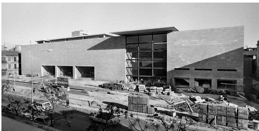
IVAM, 1988 - obras de construcción. Foto: García Poveda.
